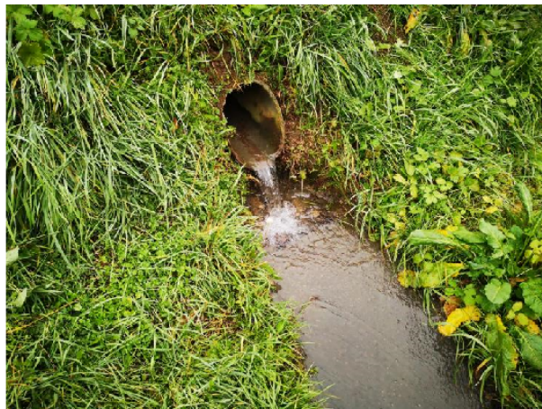
Slika 2. Mesto uzorkovanja: Izlaz otpadnih voda iz separatora na mestu upuštanja u Topčidersku reku
