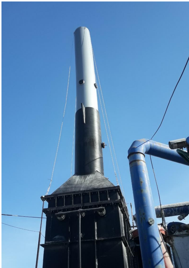
Слика 12. Скрубер за противструјно водено прање гасова
