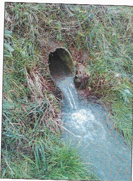
Slika 2. Mesto uzorkovanja: Izlaz otpadnih iz separatora na mestu upuštanja u Topčidersku reku
