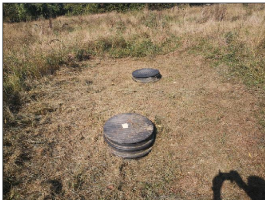
Slika 1. Mesto uzorkovanja: Separator za atmosferske otpadne vode/ulaz
