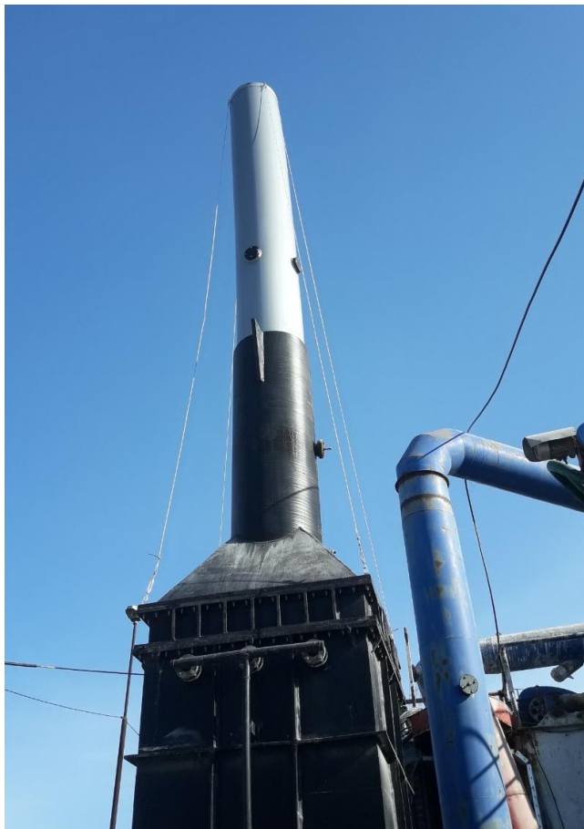
Слика 12. Скрубер за противструјно водено прање гасова
