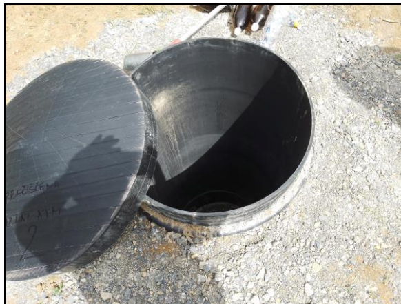
Slika 2. Mesto uzorkovanja: Separator za atmosferske otpadne vode/izlaz (šaht na ulazu u retencioni rezervoar)
