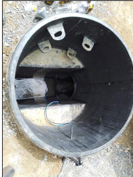
Slika 1. Mesto uzorkovanja: Šaht u koji je ugrađen merač protoka
