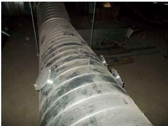
Слика 7а. Хоризонтални вентилациони канал са прирубницама за мерење
