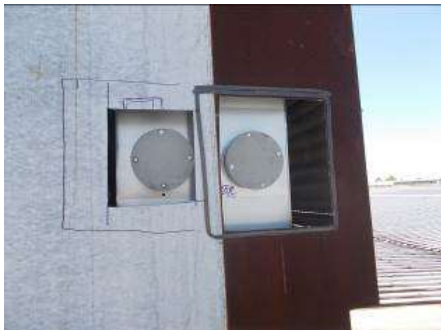
Слика 8а. Вертикални вентилациони канал са прирубницама за мерење
