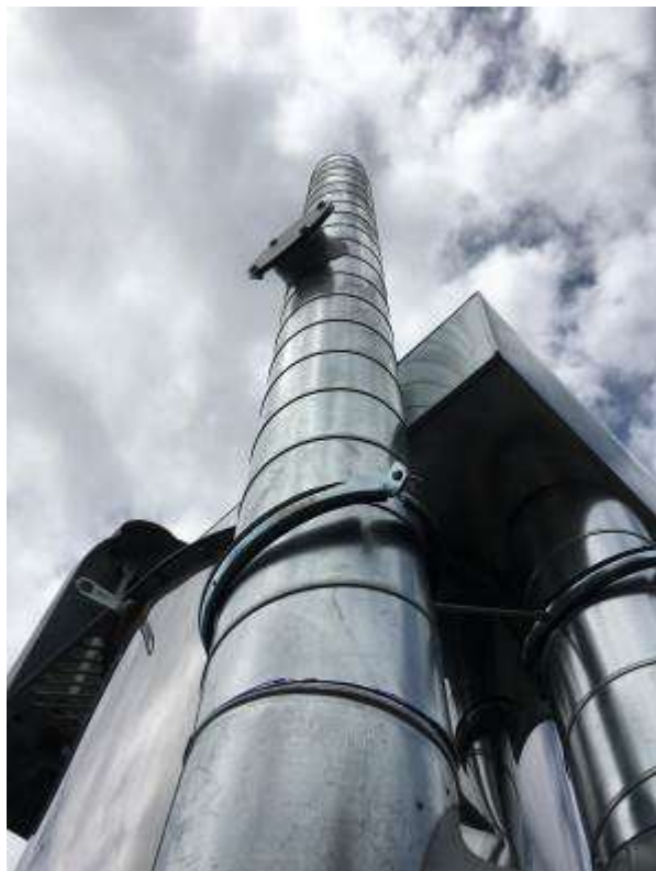
Слика 9а. Излазни емитер силоса са прирубницом
