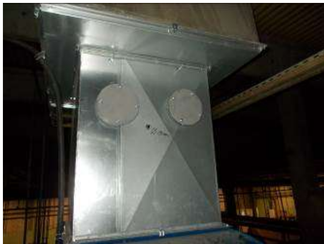
Слика 9а. Вертикални вентилациони канал са прирубницама за мерење
