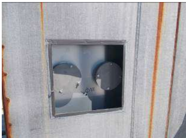
Слика 11а. Вертикални вентилациони канал са прирубницама за мерење
