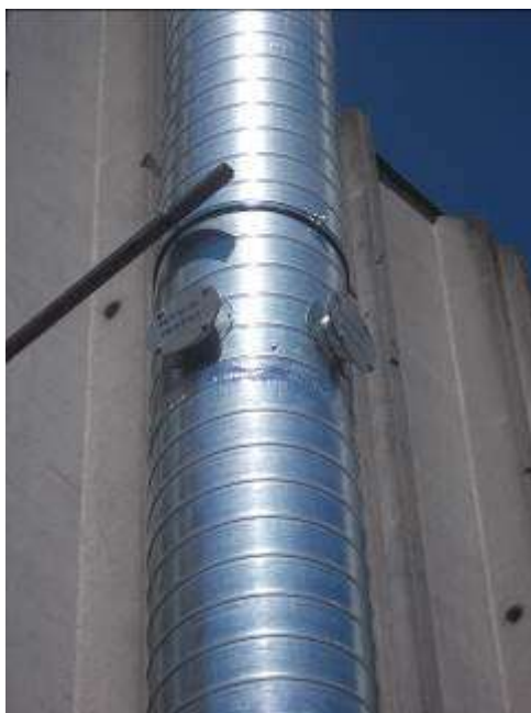
Слика 6в. Прирубнице за мерење
