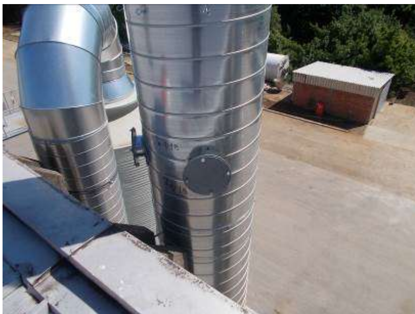
Слика 5в. Прирубнице за мерење
