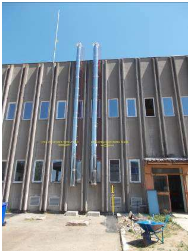
Слика 14а. Емитер са обележеним положајима мерних равни
