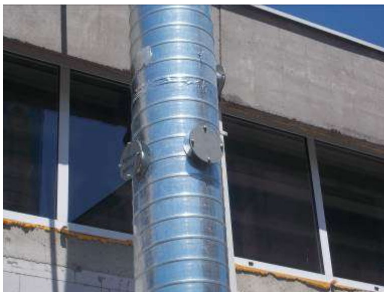
Слика 15в. Прирубнице за мерење
