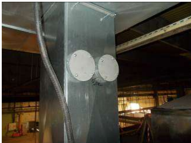
Слика 10а. Вертикални вентилациони канал са прирубницама за мерење
