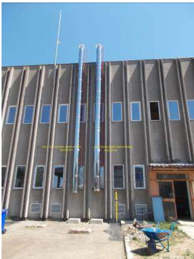
Слика 13а. Емитер са обележеним положајима мерних равни
